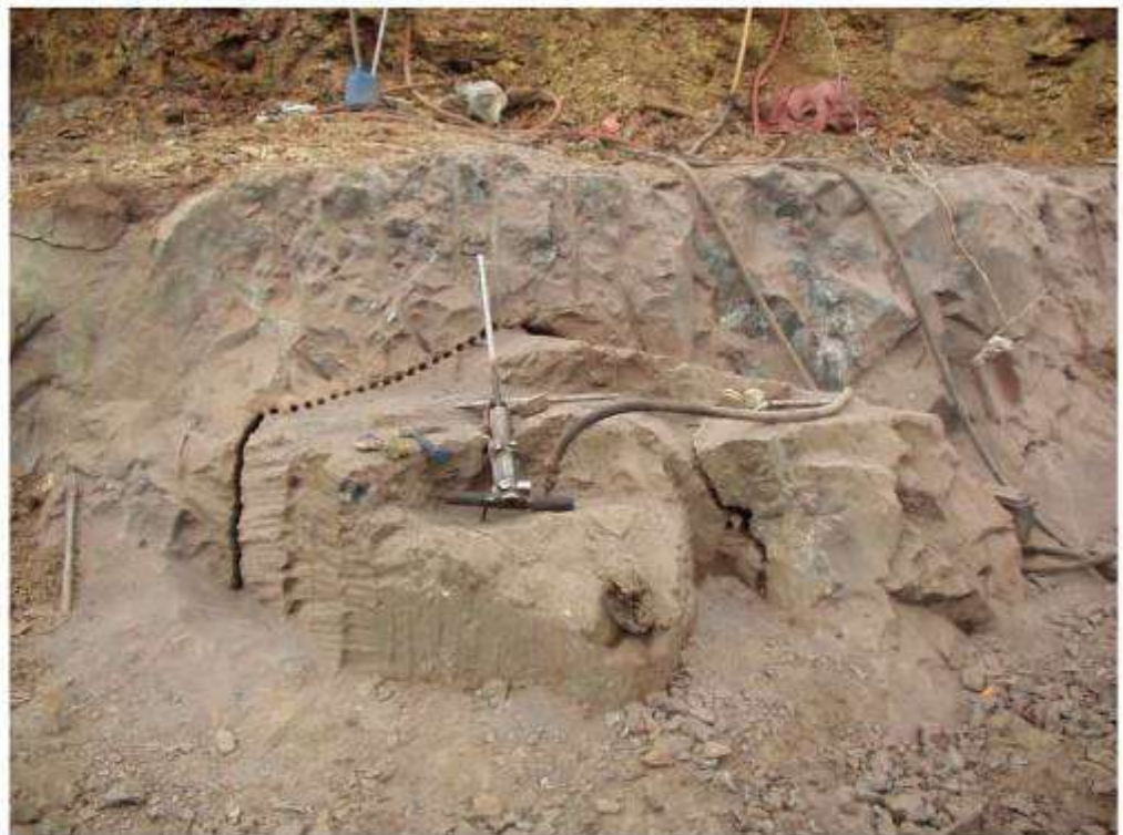
Figura 8.3-4 : En la foto superior se observa el corte con martillo neumático de una enorme geodas (aproximadamente 2 toneladas) en un frente sobre roca dura a cielo abierto. En la foto inferior, detalle de la misma geoda donde se observa la dimensión de la pieza y la cantidad de barrenos que deben ejecutarse para extraer la geoda. La metodología de corte es la misma que se utiliza para arrancar geodas en los tuneles por el método subterráneo.
